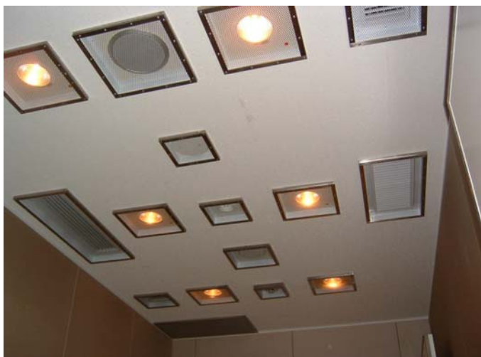
[上] シールド層 銅箔張り・天井器具シールド処理
